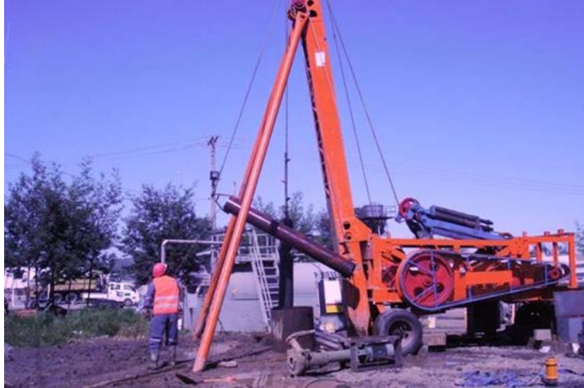
Foto 9: Equipo de percusión y herramientas (en primer plano se observa la cuchara).
