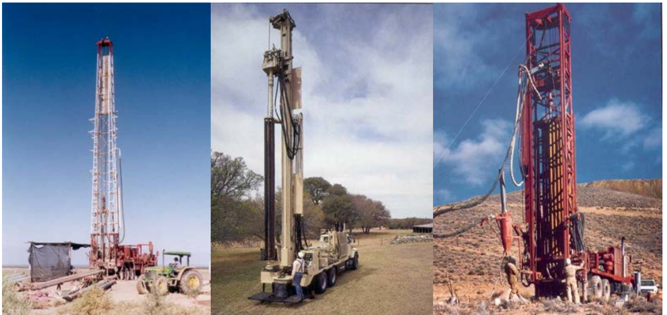
Foto 11: Equipos de perforación con sistema rotativo.
