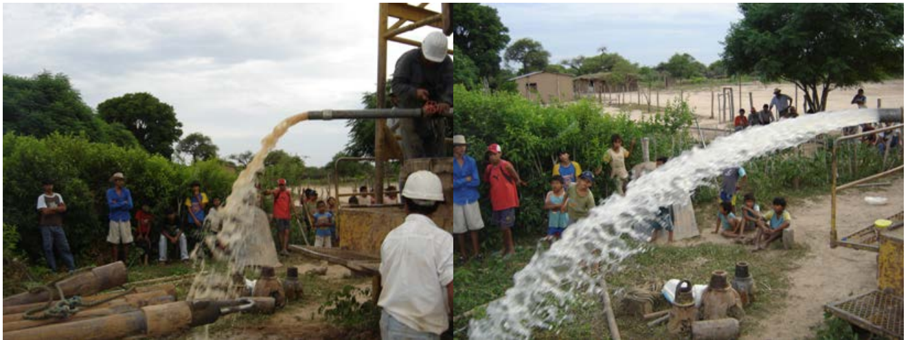
Foto 43: Izquierda, inicio del desarrollo mediante sobrebombeo (agua turbia). Derecha, pozo desarrollado (agua clara). Localidad de Vaca Perdida, provincia de Formosa.
