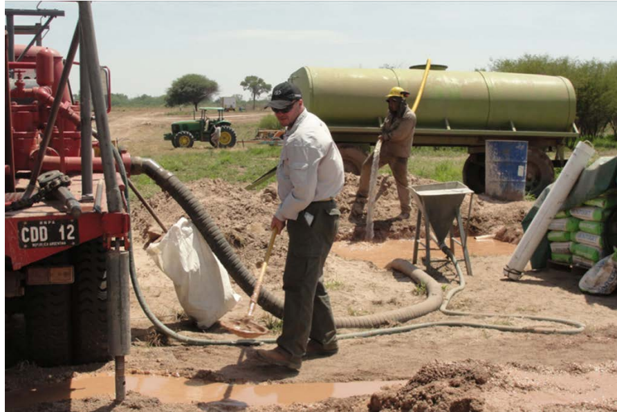
Foto 18: Piletas de inyección y circuito de inyección.
