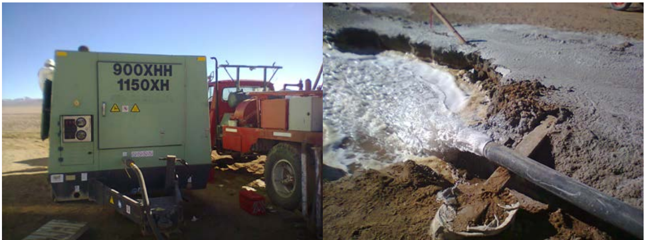
Foto 44: Desarrollo de pozo con aire comprimido. Izquierda, compresor con manguera de inyección de aire al pozo. Derecha, producción de agua. Salar del Hombre Muerto (provincia de Catamarca).
