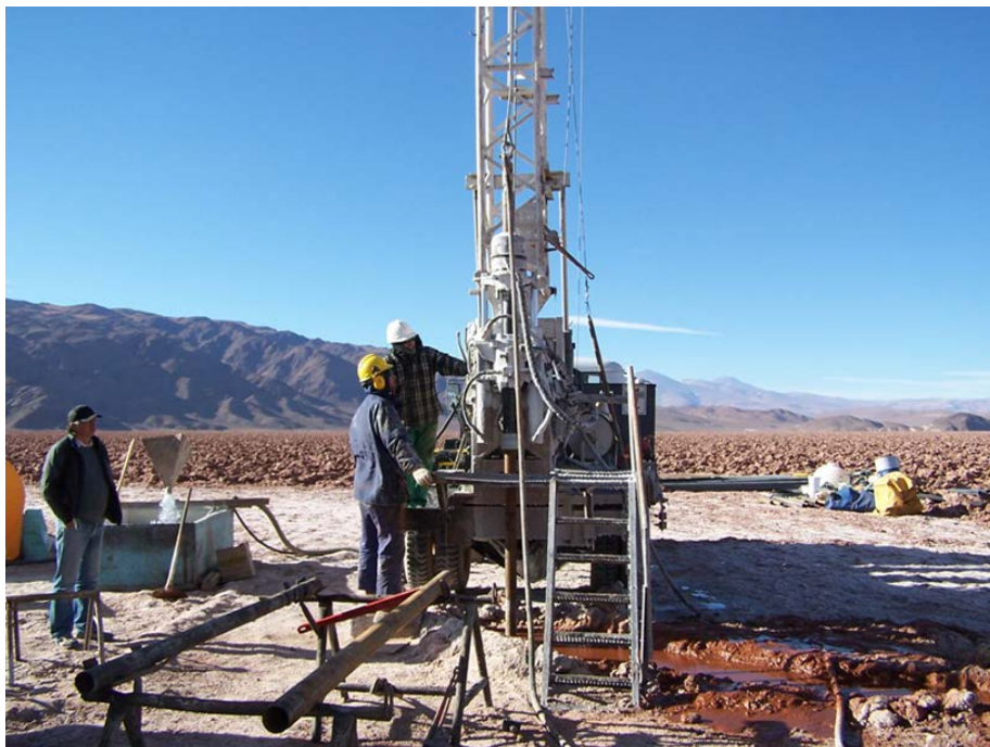
Foto 25: Barra de perforación en primer plano. Atrás equipo de perforación en funcionamiento.
