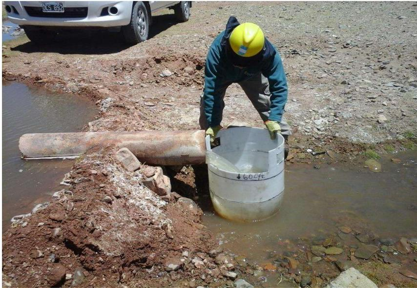
Fig.28. Aforo por el Método volumétrico.
