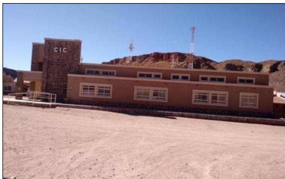
Foto 16. CIC de la localidad de Susques donde funcionan las oficinas de APS.
