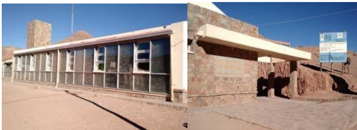
Foto 14. Vistas del exterior del Hospital de Susques.
