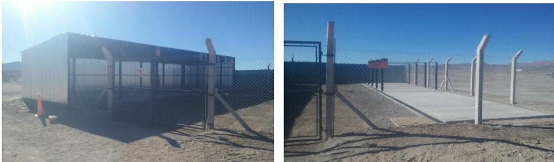
Figuras N°3 y 4. Carpetas de hormigón, rejilla perimetral y cámara de acumulación de derrames.
