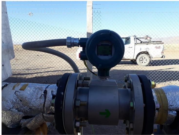
Figura N°1. Flujómetro de pozo PBI
