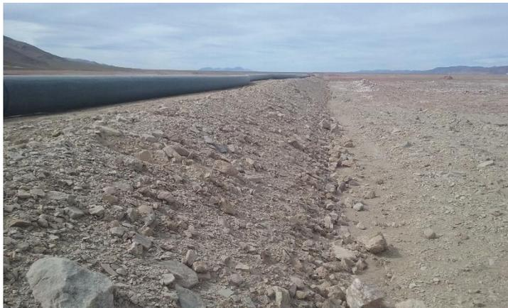
Figura N°2. Talud proporción 1:1 camino interpozo PBVI.
