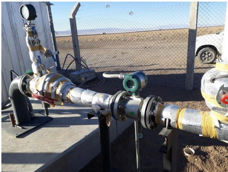
Figura N°2. Flujómetro de pozo PBI
