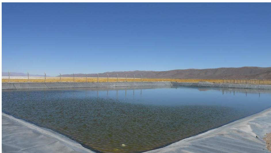
**Foto 29.** Vista de la poza de vuelco donde se dispone actualmente el efluente tratado, delimitada con alambrado perimetral.
