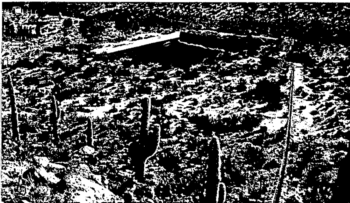
ABRA LAITE : Vista parcial del depósito de agua utilizado para riego y acequia. En el sector superior izquierdo de la foto se puede observar la casilla de cloración.
