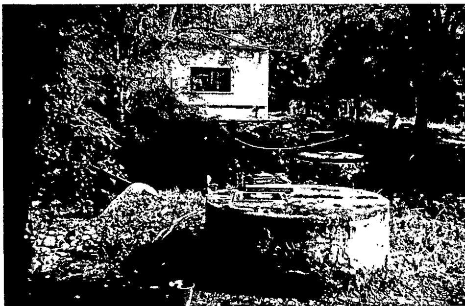
**LOS BLANCOS:** Vista del pozo N°2 con la conducción aérea sin protección térmica sobre la pequeña quebrada. En segundo plano el pozo N°1 y la escuela.
