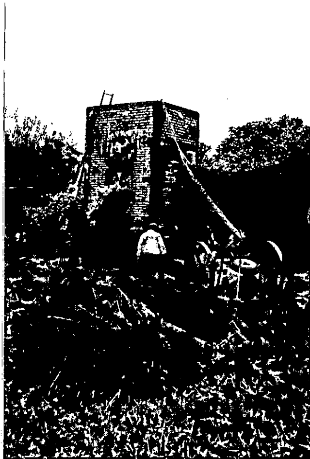
CUCHO: Depósito elevado en pésimas condiciones, falta de mantenimiento.
