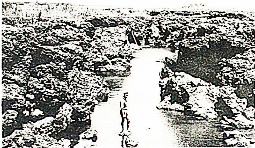
1. Ancha zanja, profunda de varios metros excavada en el lecho del río.
