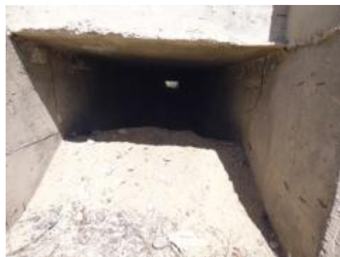
Foto 6. Alcantarilla de la ruta nacional N° 3 en el acceso a Planta Transformadora de Edersa. Vista de su interior abajo a la derecha.
