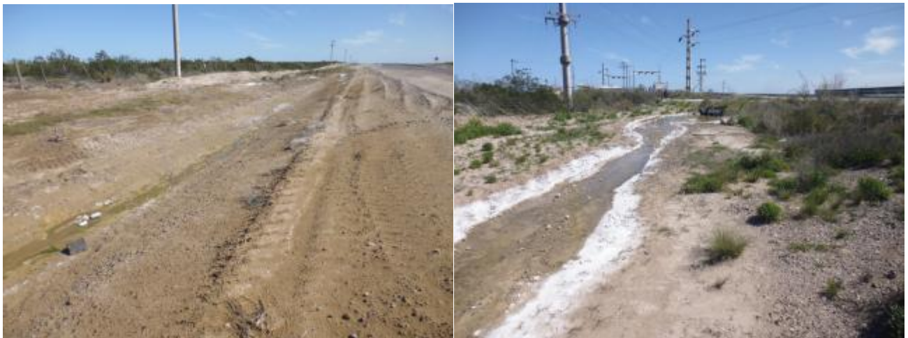
Foto 4. Izquierda, sitio donde comienza surgencia sobre banquina de ruta nacional N°3 que intercepta el drenaje donde se descarga los efluentes de la Planta Tratamiento de líquidos cloacales de Las Grutas. Derecha, otra vista del escurrimiento de los efluentes sobre la banquina próximo al acceso a la Planta Transformadora de Energía de EDERSA.
