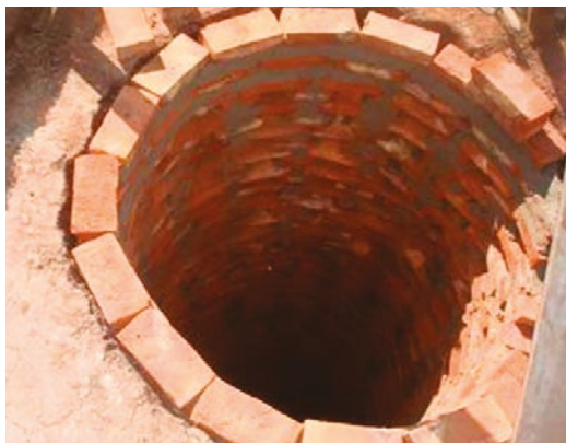
Imagen 25. Detalle de la pared interior.
