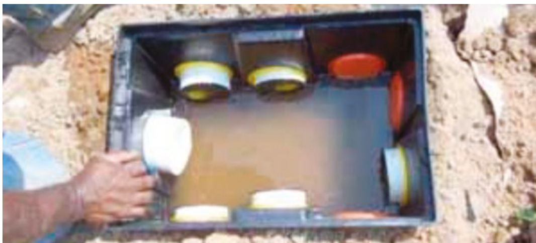
Imagen 19. Esquema de una cámara repartidora.
