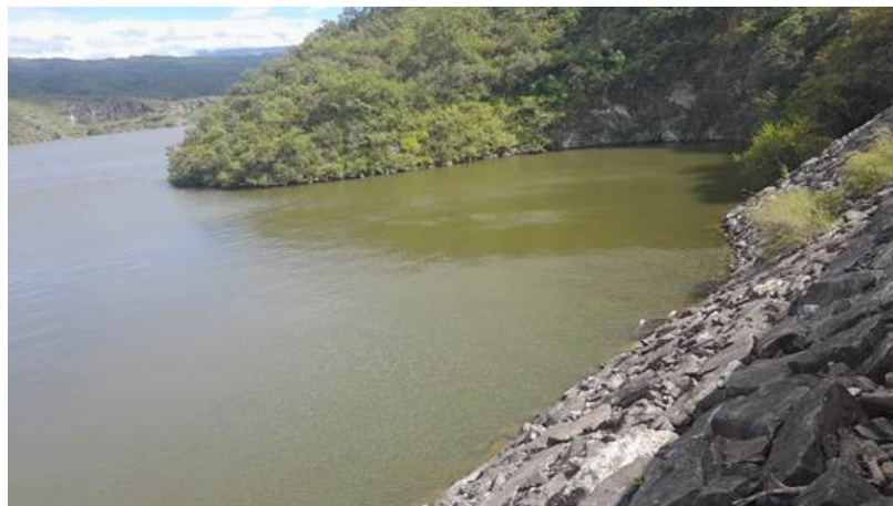
Imagen dique Las Pirquitas en marzo 2022
